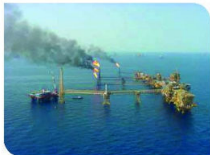
Fig. 4.35 El Complejo Cantarell, ubicado en el mar de la Sonda Campeche, es el segundo más importante en el mundo.
