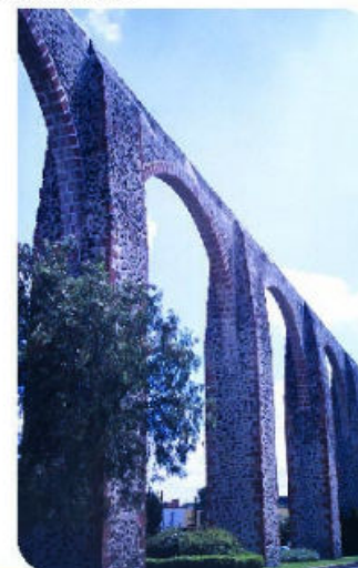
Fig. 2.4 El acueducto de Querétaro, una de las obras urbanas hidráulicas más importantes de Nueva España.
